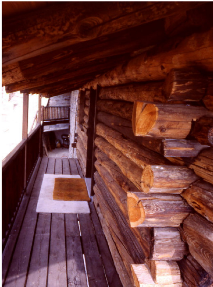
R ascard originale, costruzione a blockbau, restaurato e rimontato - dettaglio incastro-ballatoio
