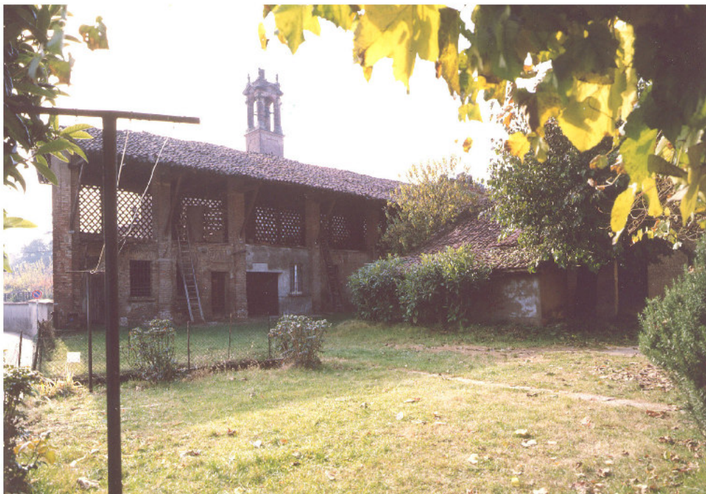
Il fienile con il campanile del convento in secondo piano
